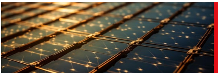
Impianti con pannelli solari
